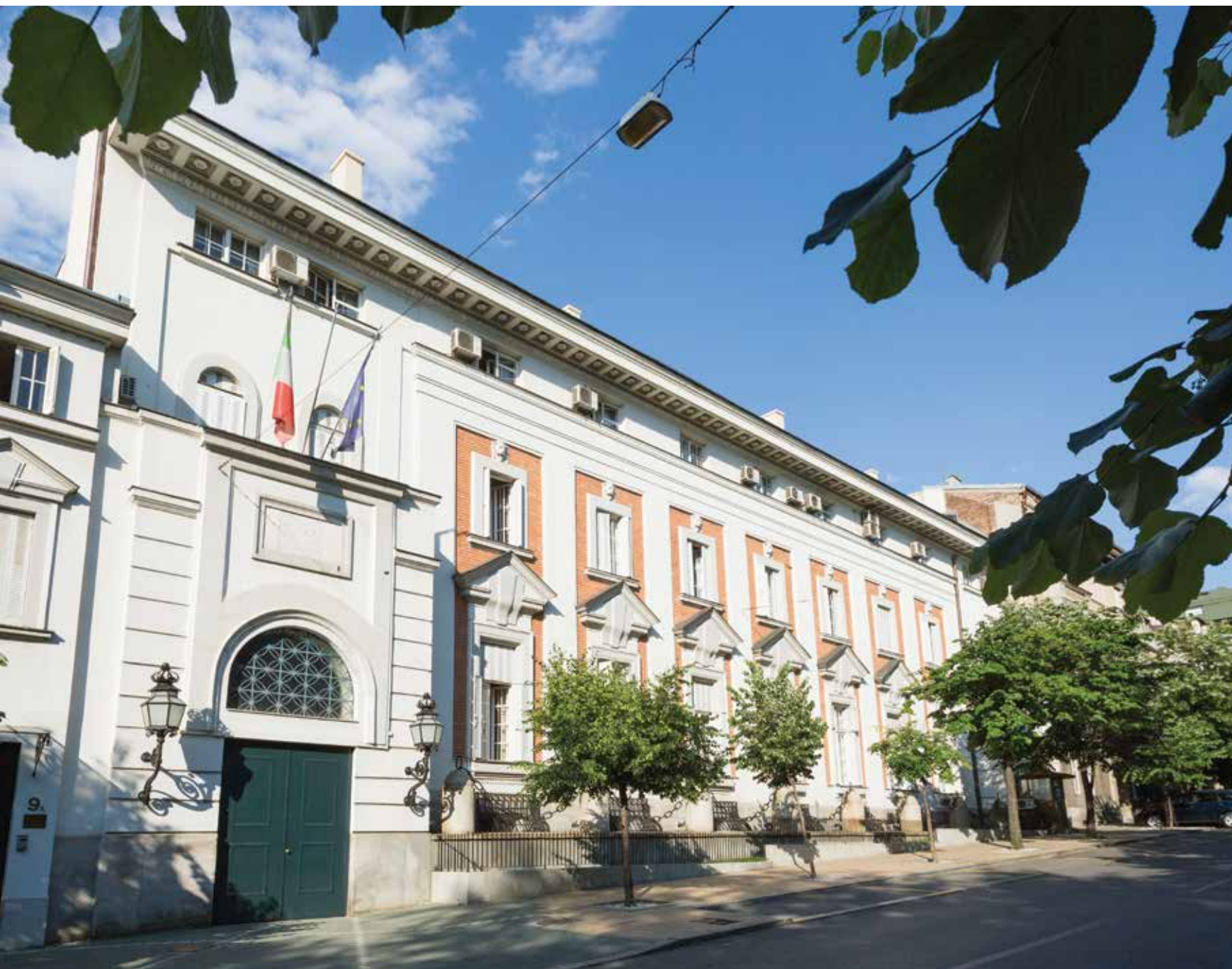
L'ELEGANTE FACCIATA DELLA SEDE DELL'AMBASCIATA A BELGRADO IN VIA BIRČANINOVA 9 ELEGANTNA FASADA ZGRADE AMBASADE U BEOGRADU U ULICI BIRČANINOVA 9
